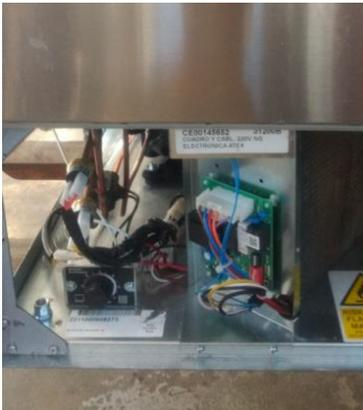
**2-** Desconectar el cableado y retirar la placa presionando los remaches que la sujetan e instalar la nueva placa conectando de nuevo el cableado.
